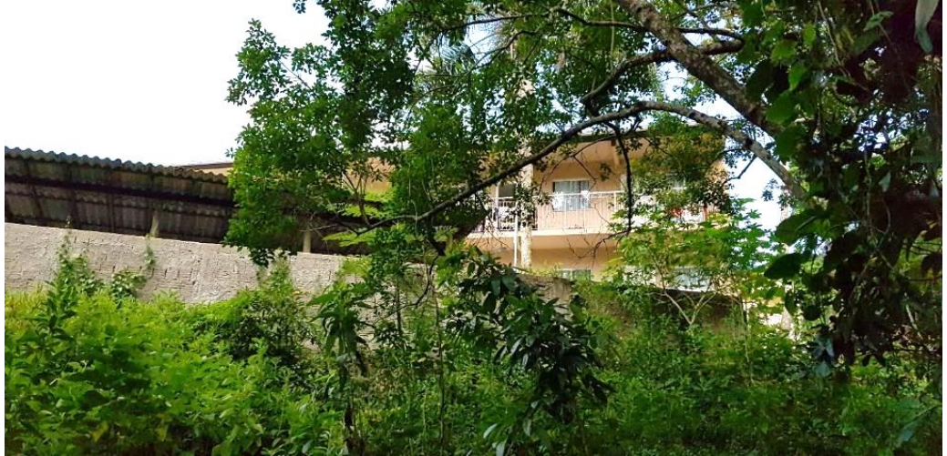
Figura 4 – Vista do fundo das casas no fim da servidão Arnaldo de Lisboa, onde segundo o Geoprocessamento corporativo passaria o curso d'água.
