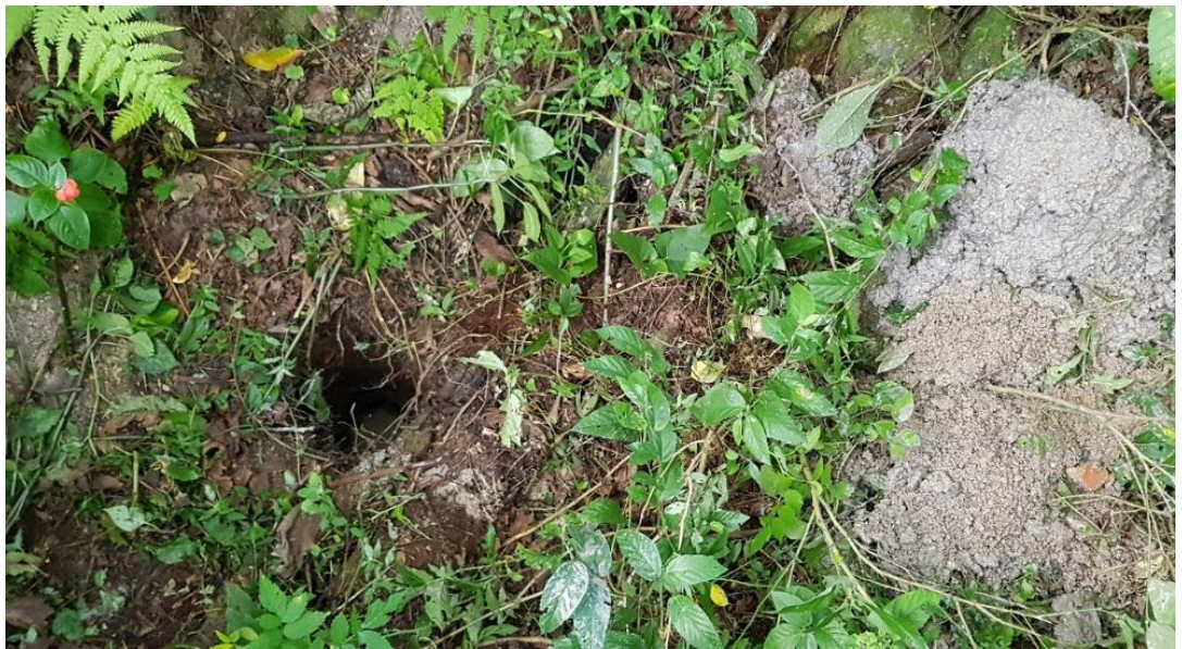
Figura 5 – Início da tradagem do piezômetro. Coordenadas 27°30'20.04"S/ 48°30'56.08"O
