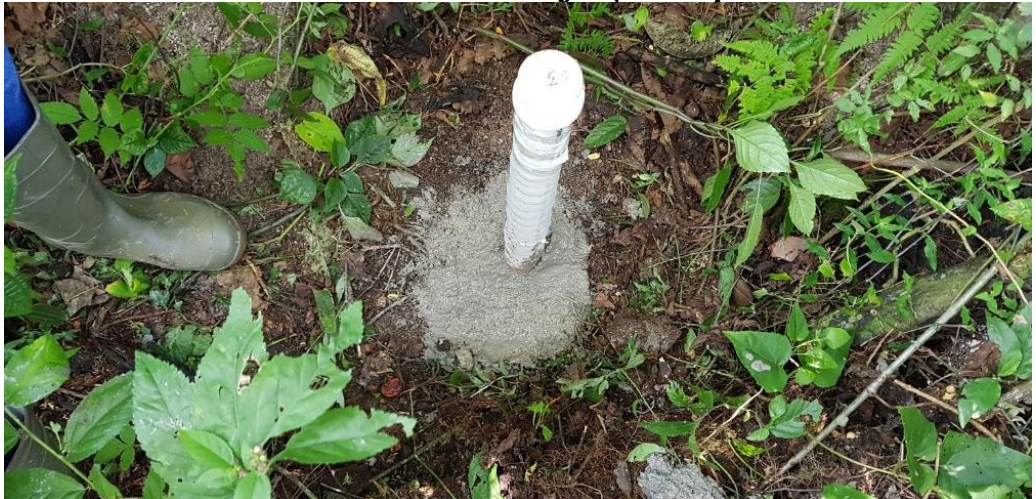
Figura 7 – Piezômetro instalado e finalizado
