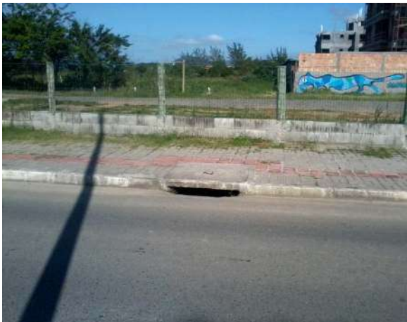
Foto 03 – Infraestrutura de microdrenagem.
