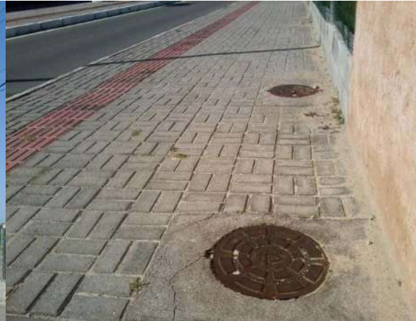
Foto 02 – Caixas de ramais da rede de esgoto.
