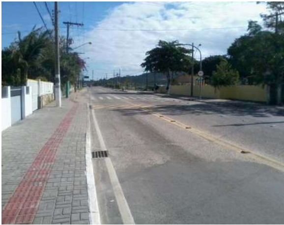
Foto 15 – Infraestrutura urbana Av. Pequeno Príncipe.
