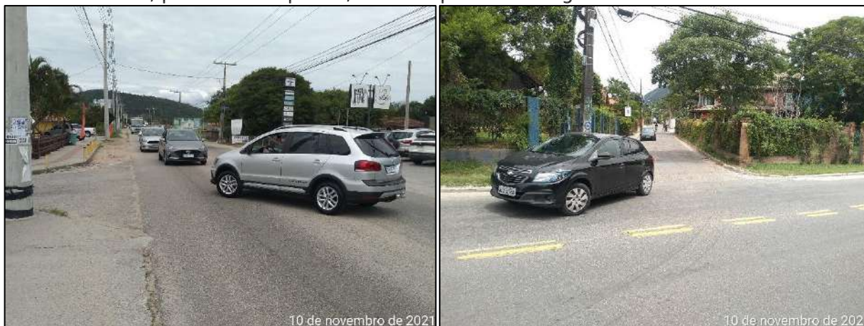
Figura 8: Acessos viários à Servidão Elpídio da Rocha, registro à esquerda o acesso pela Rod. SC-406 sem uma via arterial e ponto de tangência mínimo de 100m e à direita, pela Av. Campeche, sem um ponto de tangência mínimo de 15m.
