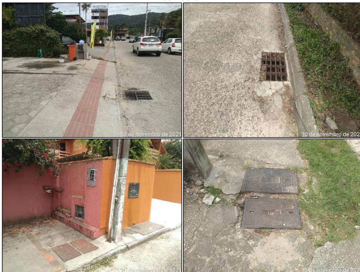
Figura 7: Alguns registros da infraestrutura urbana consolidada na Servidão Elpídio da Rocha.
