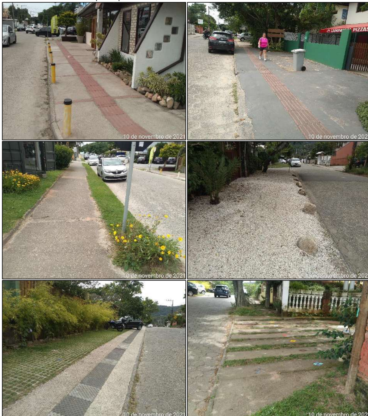
Figura 10: Na Servidão Elpídio da Rocha, no trecho da via mais larga, os passeios também apresentam maior largura e acessibilidade a pessoas com deficiência, principalmente nos lotes de usos comerciais.
