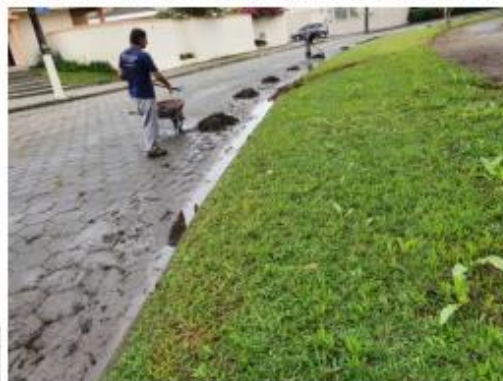
Limpeza meio-fios (revitalizando a praça)
